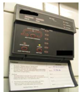
Kuva 23. (Oikealla) Palohälytyskeskusta hallinnoidaan näistä näppäimistä, tässä näkyy myös merkkivaloja.
