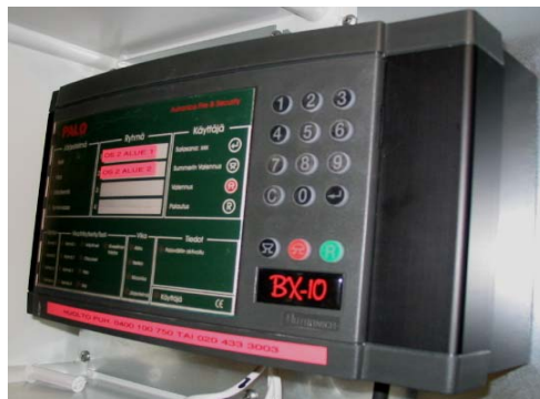
Kuva 7. Palovaroitinkeskus
