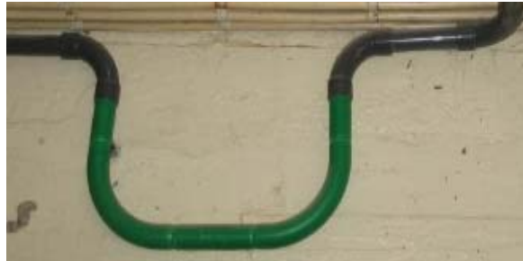
Kuva 16. Näyteilman kondensaatiovesi poistuu tässä putkiston mutkasta
