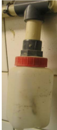
Kuva 30. Kondenssiveden keräys
