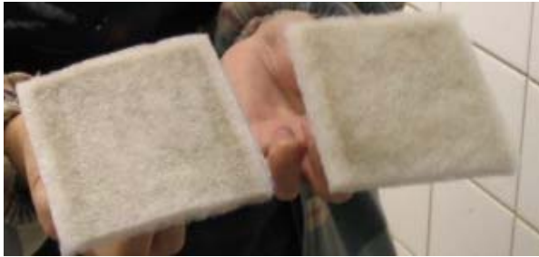
Kuva 37. Laitteisto E:n suodattimet olivat melkein puhtaat seuranta-ajan toukokuussa.
