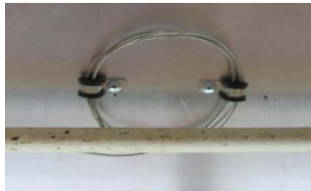
Kuva 13. Kapillaariputken silmukka, taustalla peltilevy
