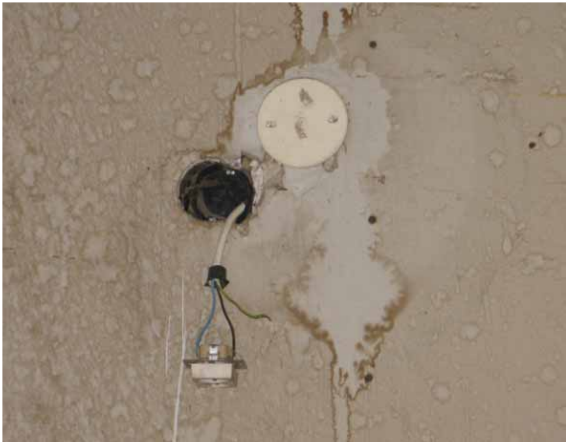
Kuva 12. Kiinnittämätön pistorasia.
