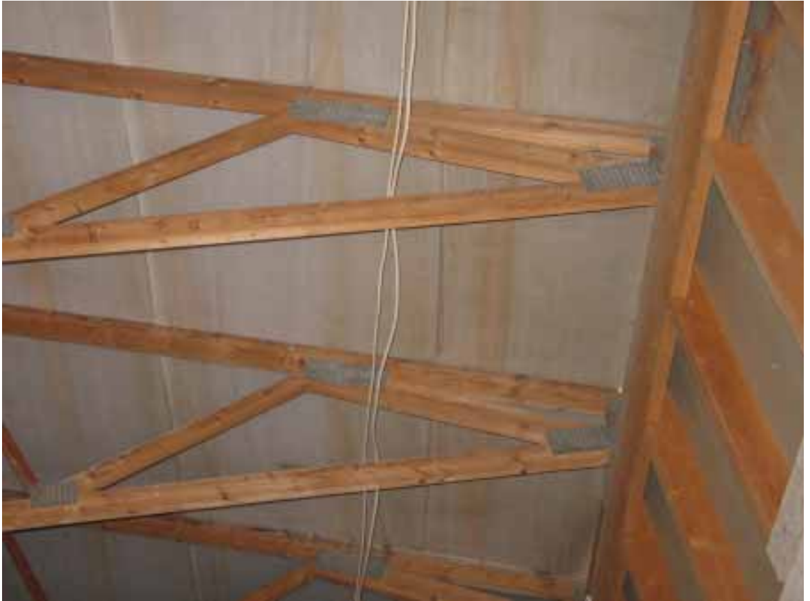
Kuva 20. Kiinnittämättömiä kaapeleita.
