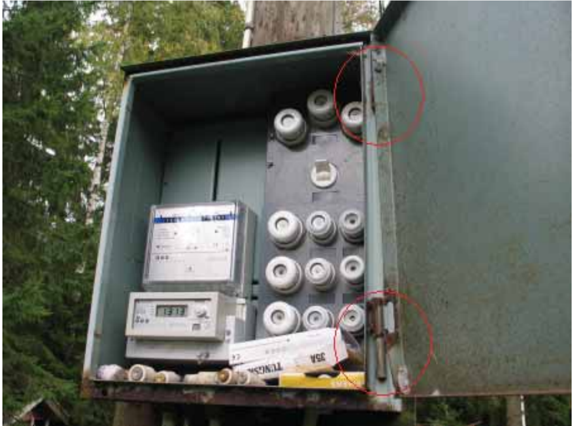
Kuva 8. Ruostevikaisia keskuksen saranoita.
