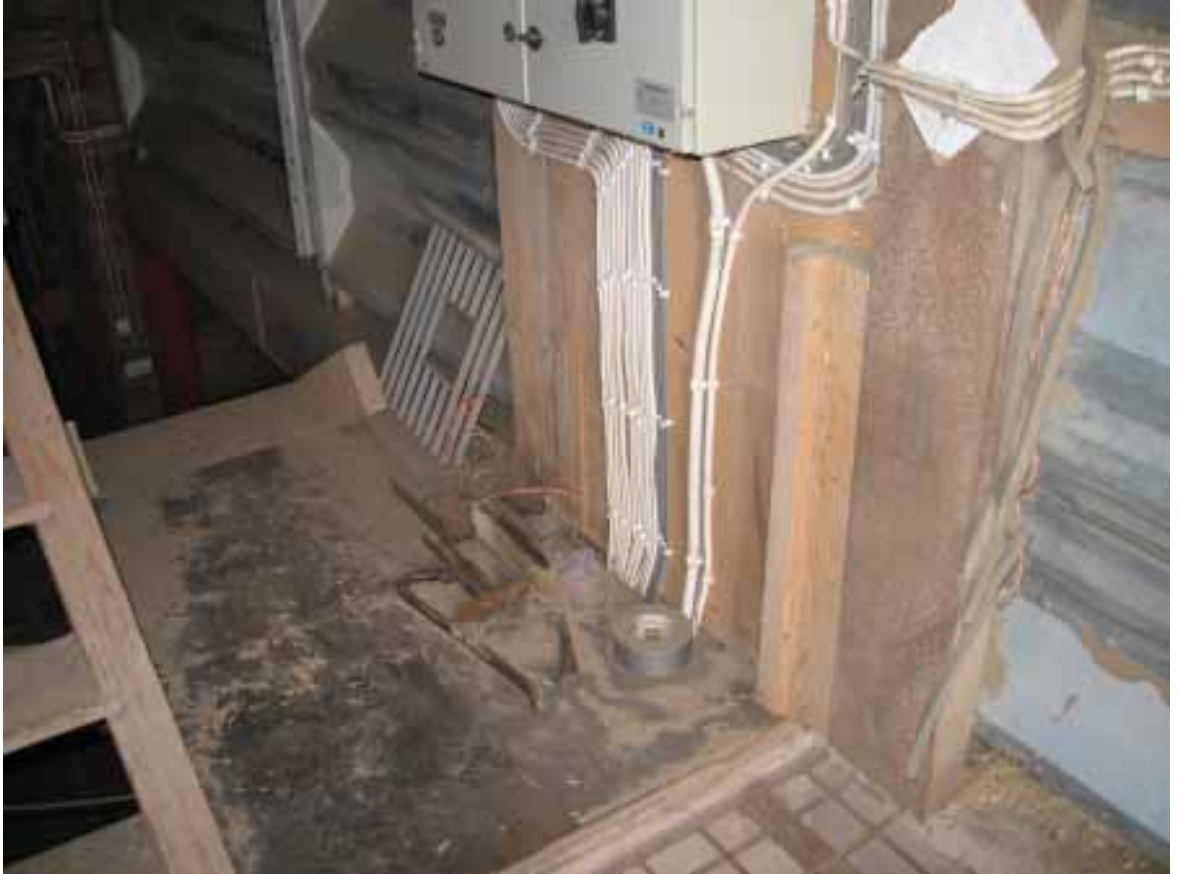
Kuva 11. Suojaamattomia kaapeleita.
