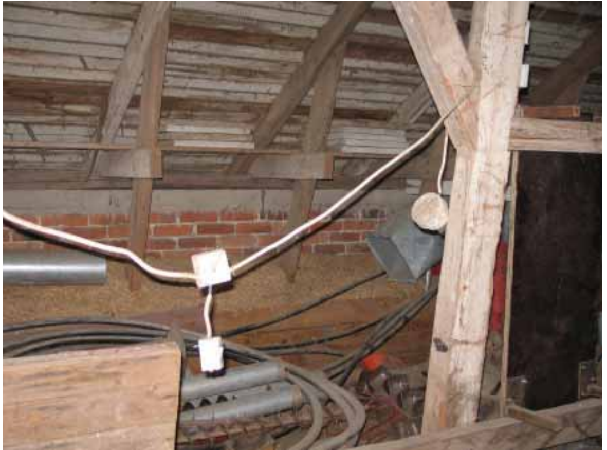
Kuva 15. Kiinnittämättömiä sähköasennuksia.
